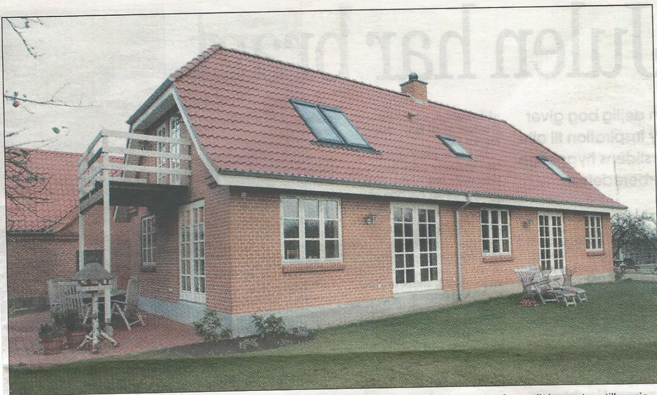
Nu - sådan ser facaden mod syd ud en novemberdag 2004. Den del af huset, der er til venstre for nedløbsrøret, er tilbygningen. Med et murearbejde til og kan man faktisk ikke se, hvad der er nyt og gammelt. På taget er valmene kommet frem igen.
